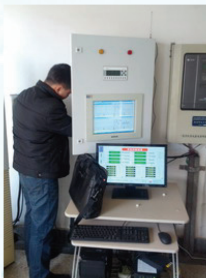
工程师在安装调试
